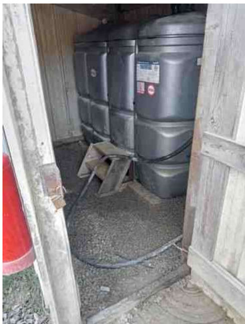
Photo des bacs double peau ou sur rétention
