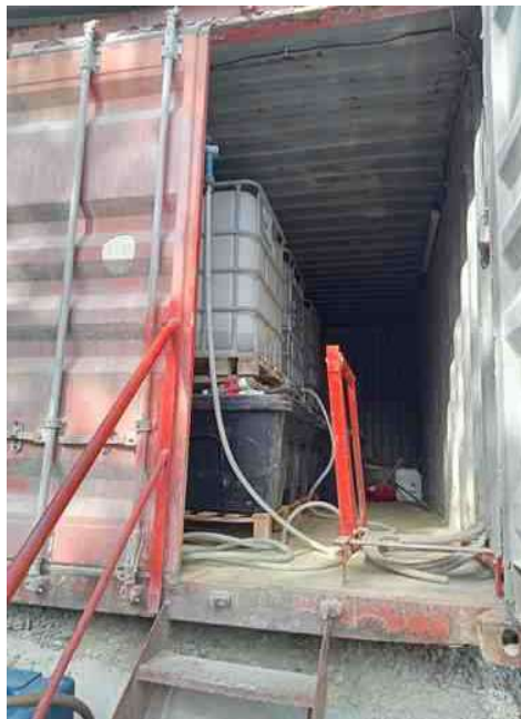
Photo des bacs double peau ou sur rétention
